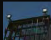
Techo de la cabina (dos lámparas)
