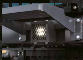
Bajos de la cabina (una lámpara)
