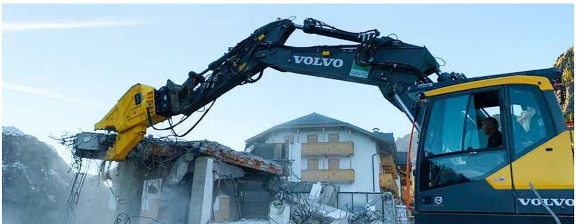
A utilização a longo prazo é garantida através da conceção extremamente robusta dos Pulverizadores de demolição. As peças de desgaste são ambas rapidamente substituíveis no local.
