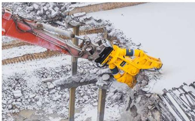
Dois mandíbulas de movimento independente eliminam a força de deslocação, reduzindo assim os níveis de tensão.
