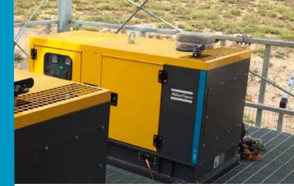
Cuando necesita energía temporal, es posible que un solo generador no sea siempre la solución más eficaz. ¿Varía la carga de la aplicación? ¿Necesita alguno de los generadores de su flota más potencia? Si ha respondido sí a alguna de estas cuestiones, una planta de energía modular (conexión en paralelo de varios generadores) es la solución más eficaz en su caso.
